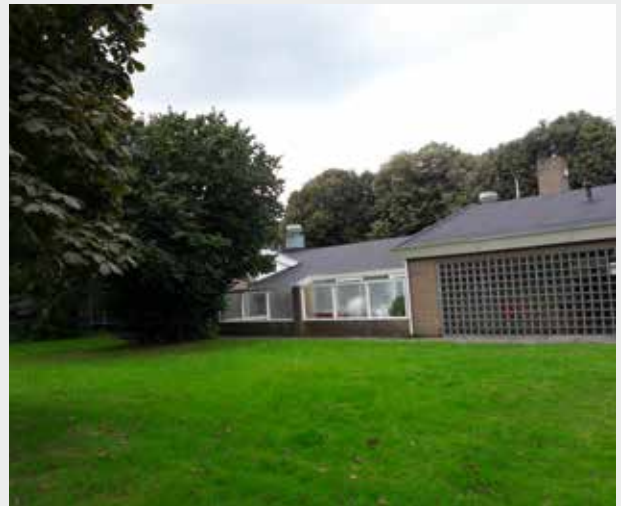
Terras annex fietsenstalling aan de achterkant
